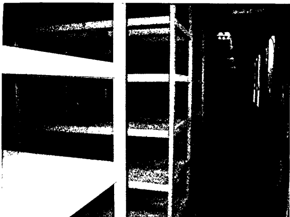
1. Objekt „B“ vestavěné regály přízemí
