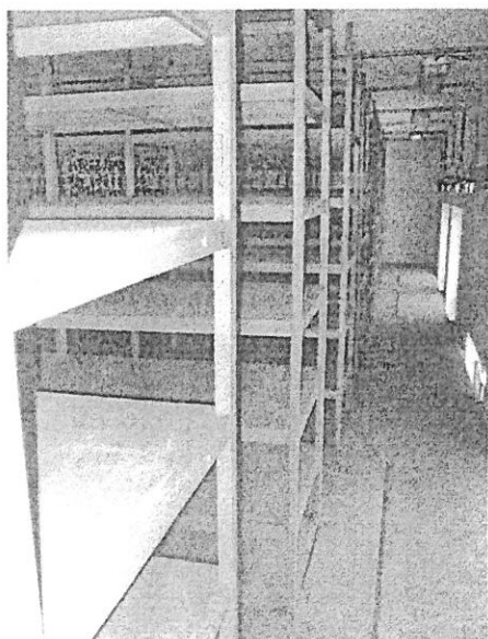
3. Objekt „B“ vestavěné regály přízemí v 2NP
