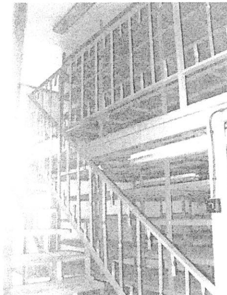
2. Objekt „B“ schodiště do 2NP
