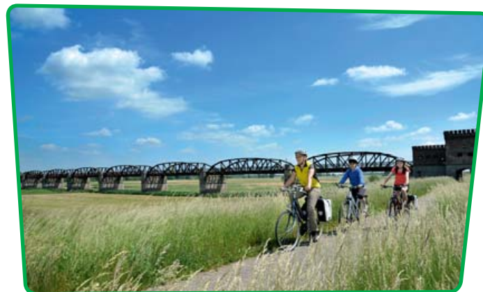
Železniční most u Dömitz
